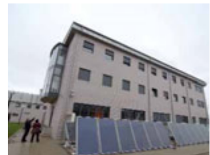
Nuevo albergue que se construye en Candina. Foto: Joaquín Gómez Sastre.
