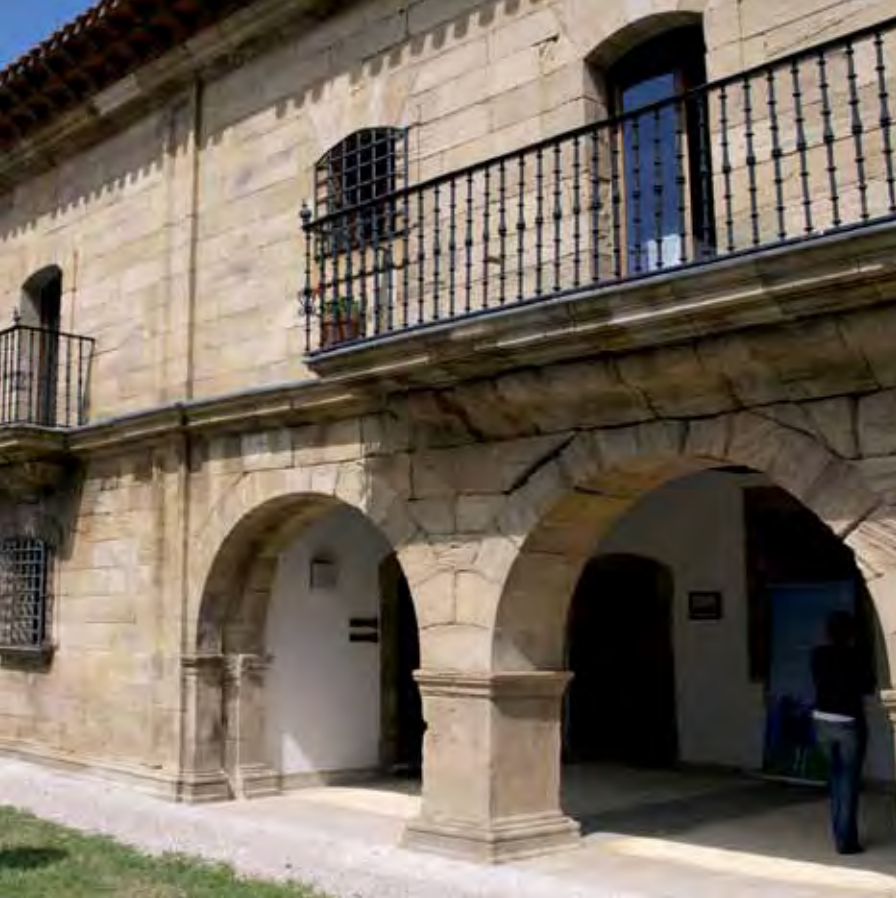
Fachada de la Casa Rectoral de Puente Pumar. Foto: Javier Rosendo.
