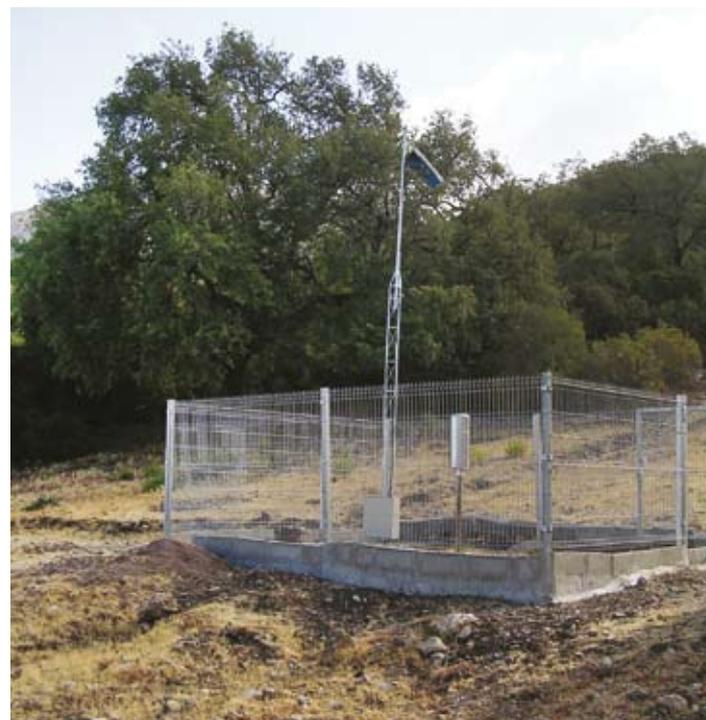
**Estación automática de control pluviométrico y nivel de un sondeo**
