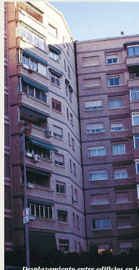
**Desplazamiento entre edificios en la ciudad de Murcia como consecuencia de fenómenos de subsidencia del terreno a causa del descenso piezométrico**
