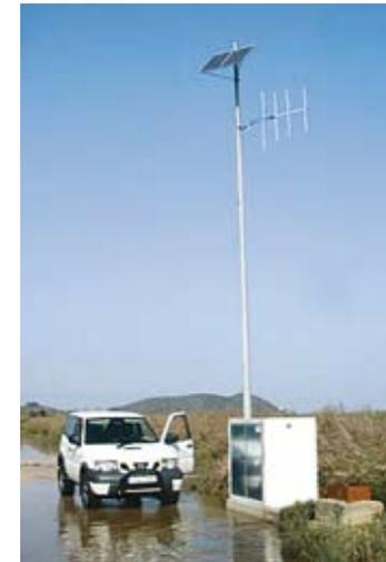
*El control de un sondeo puede hacerse a través de sistemas de seguimiento remoto alimentado por energía solar*
