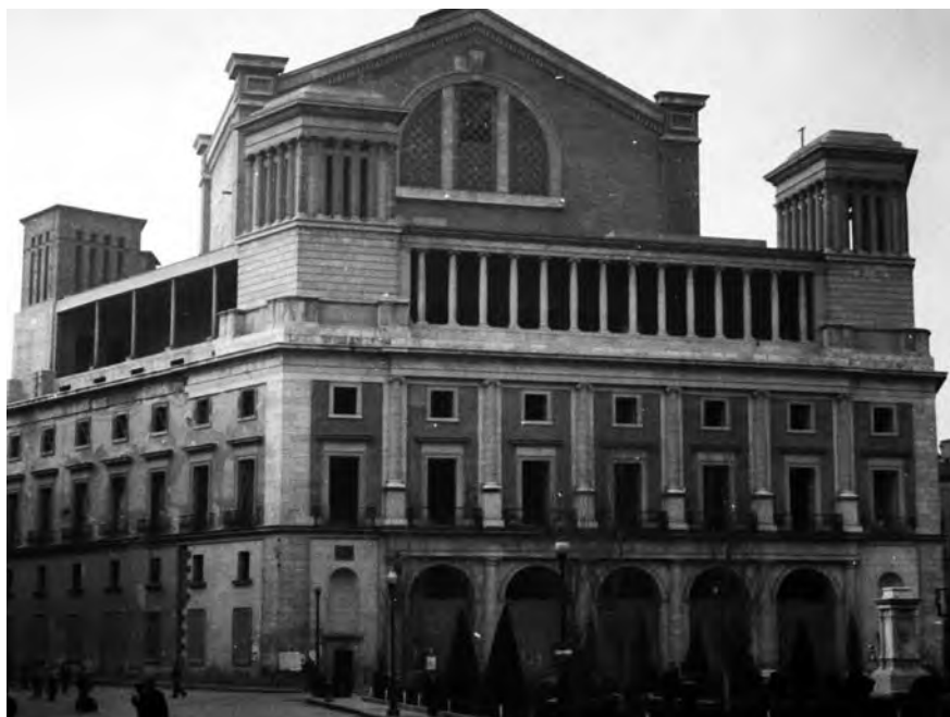
Exterior del Teatro Real (Madrid), antes de su última reforma
