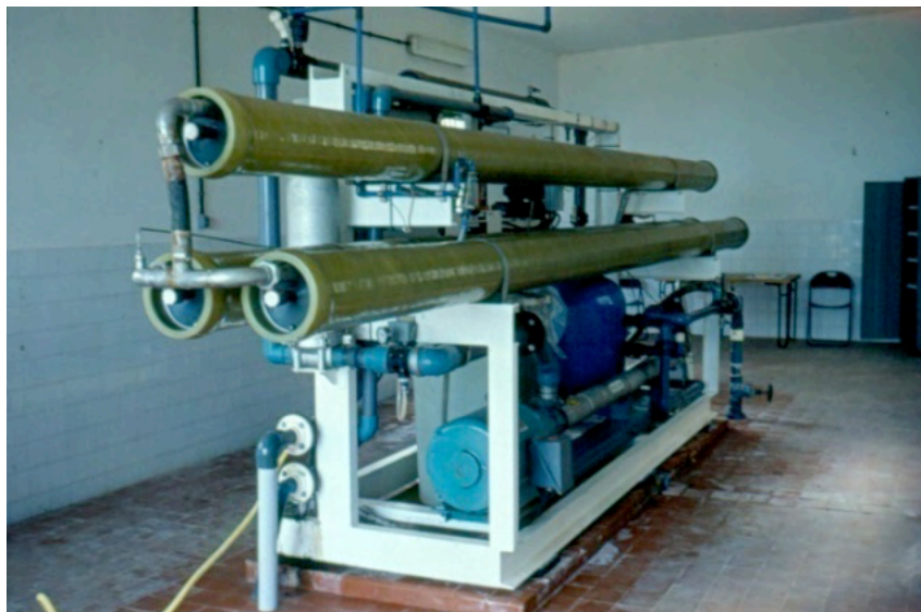
Pequeña planta para desalinizar agua subterránea salobre para riego, Gáldar. N. Gran Canaria
