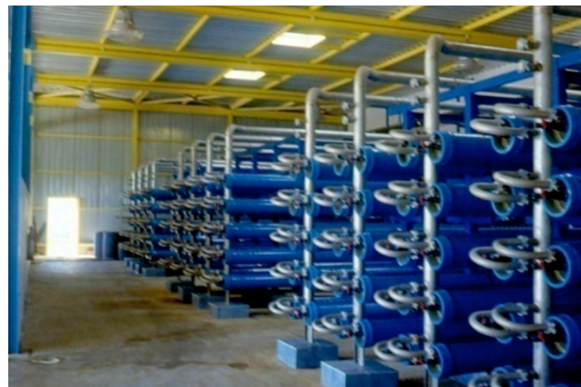
Desalinización de agua marina por osmosis inversa. Abastecimiento del área turística de Maspalomas–El Inglés
