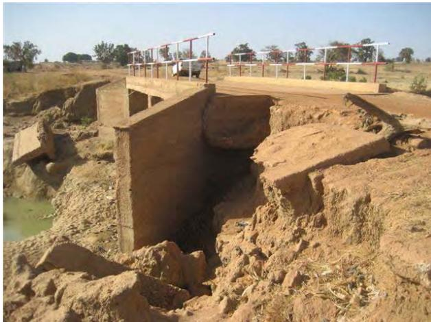
Figura 16: Daños causados por las riadas y la ausencia de mantenimiento.
