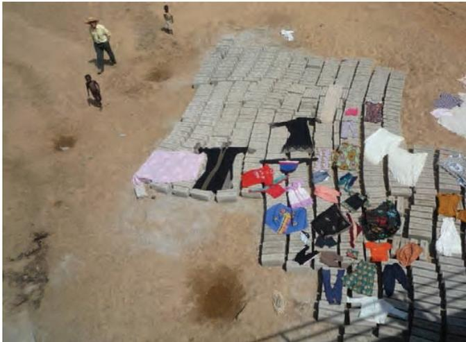
Figura 24: Pozos y bovedillas fabricadas al sol
