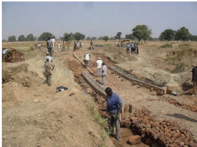
Figura 32: Construcción de la pista con mano de obra local (Togo).
