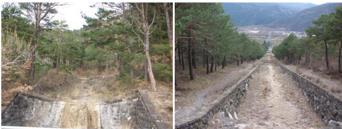
Figura 12. Estado en marzo de 2012 del canal escalonado de tramos erosionables, construido en 1904, que discurre por el eje del cono de sedimentación del torrente de Arratiecho para dirigirse al curso del río Gállego, en la sección que le atraviesa la carretera N-206, tras haber sido limpiado recientemente. Imagen izquierda: el canal visto hacia aguas arriba desde la carretera N-206 (esta imagen se corresponde con las fotografías de la Figura 5). Imagen derecha: el mismo canal inmediatamente aguas abajo de la citada carretera.
