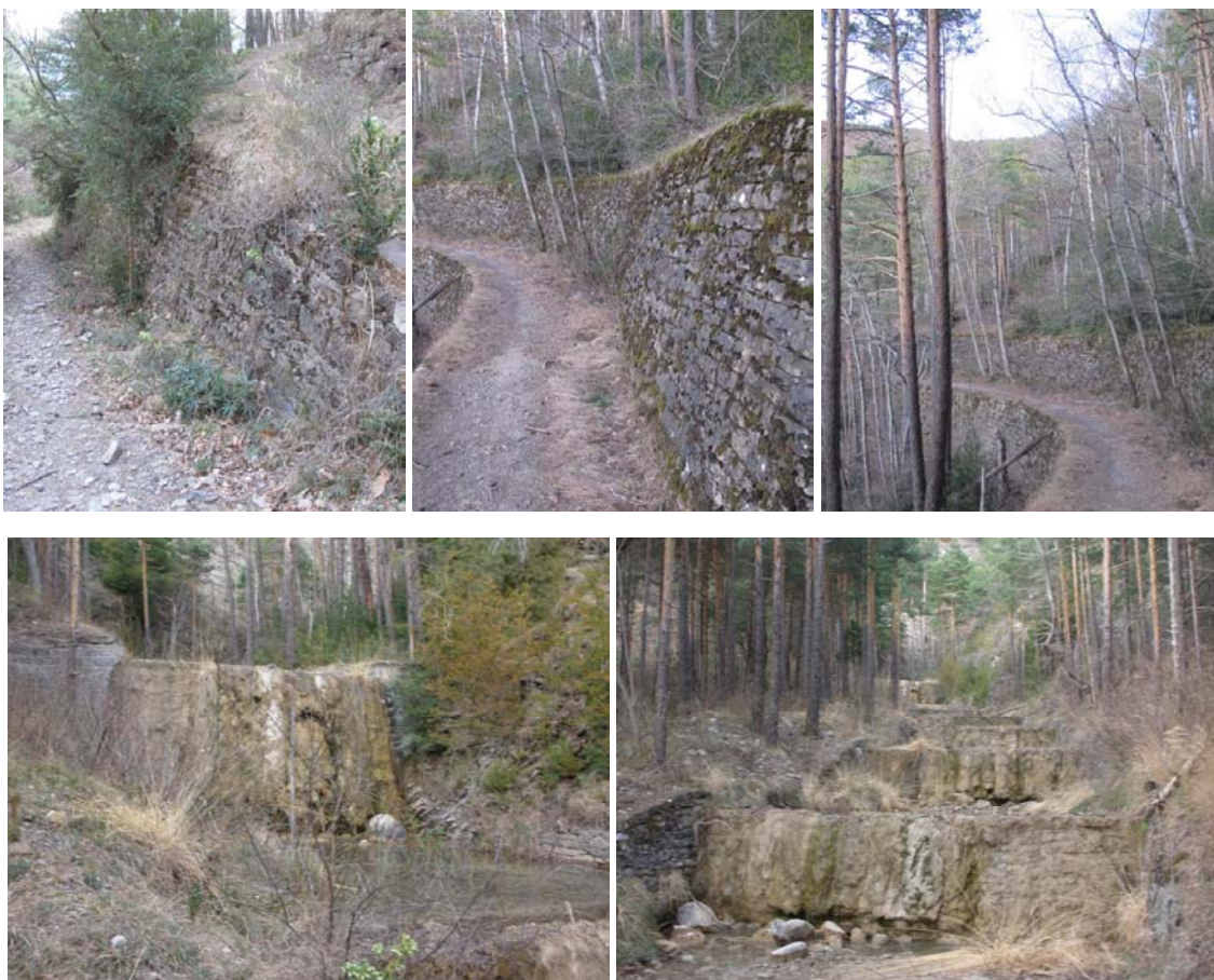
Figura 11. Imágenes superiores: Detalles del estado que presentan en marzo de 2012 los trabajos de nivelación del terreno realizados en la vertiente directa al torrente de Arratiecho entre 1901-04. Imágenes inferiores. Izquierda: dique de mampostería hidráulica de primer orden número 3, situado en el vértice del cono de sedimentación del citado torrente. Derecha: tramo encauzado del torrente en cuestión aguas abajo del dique de mampostería hidráulica de primer orden número 3, que aparece al fondo.
