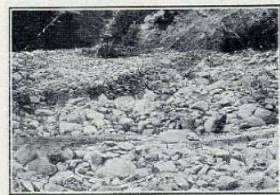
Paso del torrente por la ladera de la carretera Ce Biescas a Gabín antes de realizarse las obras
